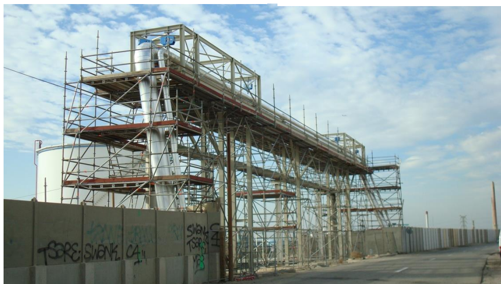
ECHAFAUDAGE/CALORIFUGE - RESEAU LIGNE VAPEUR
