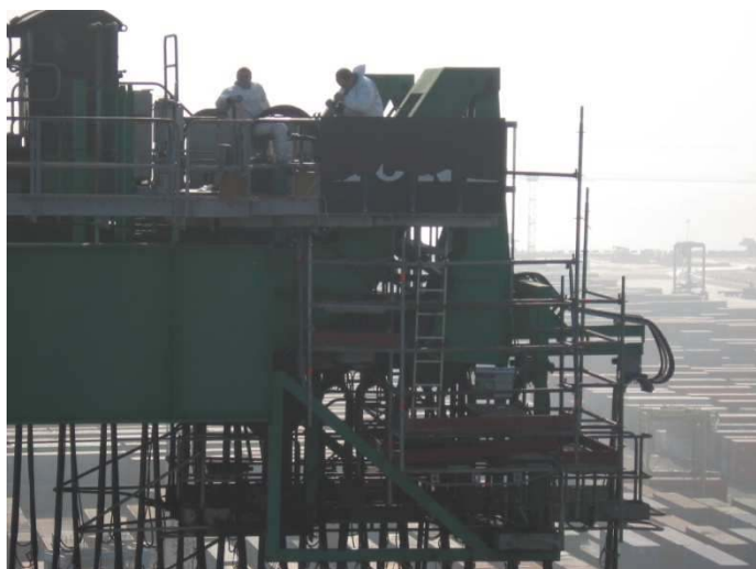
ECHAFAUDAGE SUSPENDU + 40 M - PORTIQUE PAM
