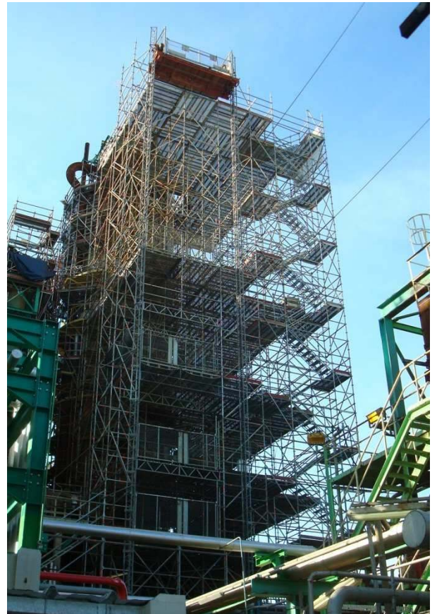
ECHAFAUDAGE DE COLONNE PLATELAGE ASCENSEUR MONTE-CHARGE
