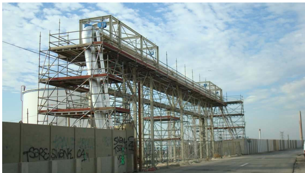
ECHAFAUDAGE/CALORIFUGE - RESEAU LIGNE VAPEUR
