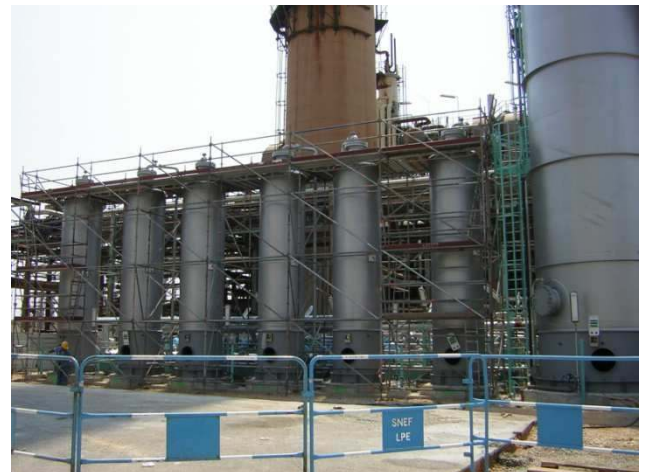
ECHAFAUDAGE DE SILOS
