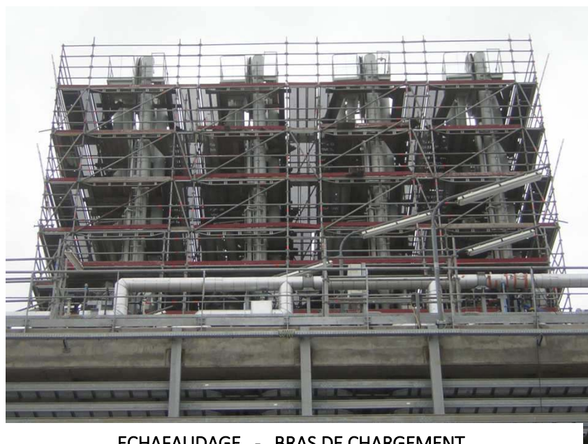
ECHAFAUDAGE - BRAS DE CHARGEMENT
